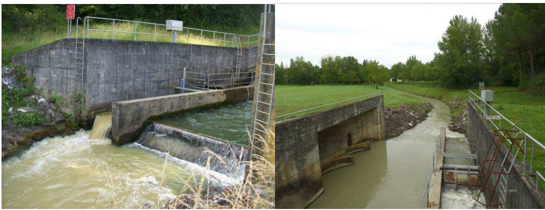
Figure 28 : Ouvrage de restitution
