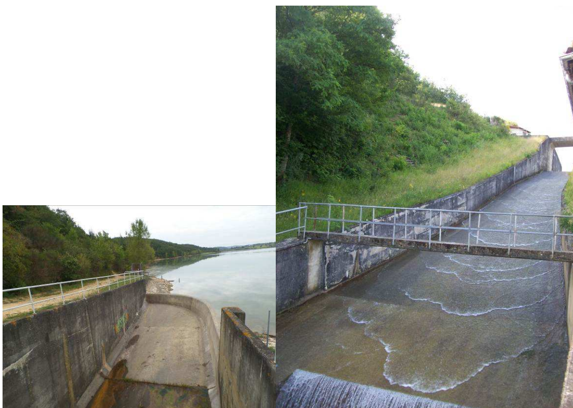
Figure 17 : Entonnement et coursier de l'évacuateur de crue principal
