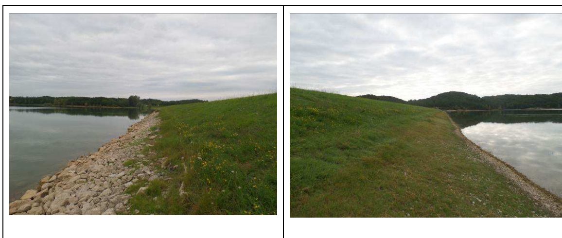
Figure 6 : Parement amont du barrage
