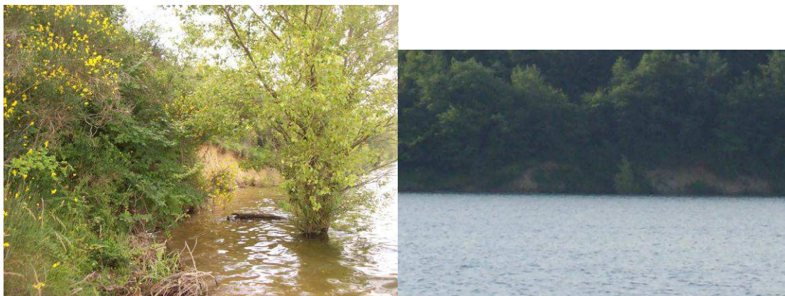
Figure 35 : Glissements observés sur les rives de la retenue
