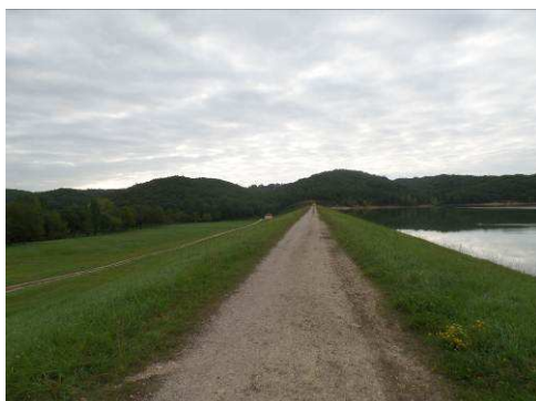
Figure 10 : Crête du barrage
