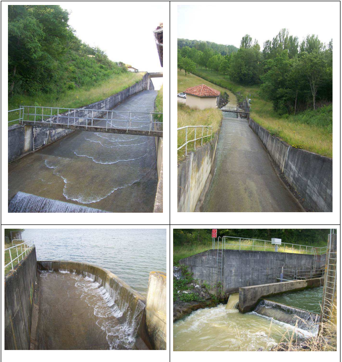
Figure 1 : Photographies de l'évacuateur de crue principal
