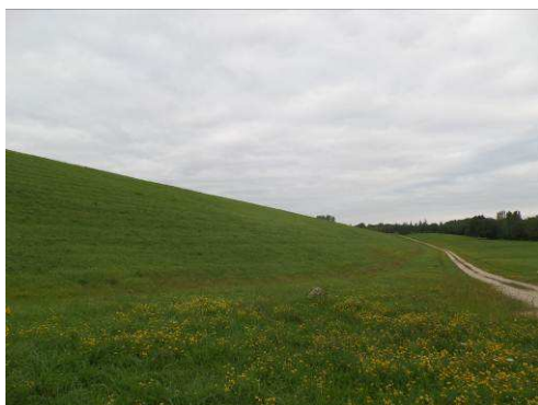
Figure 12 : Talus aval du barrage
