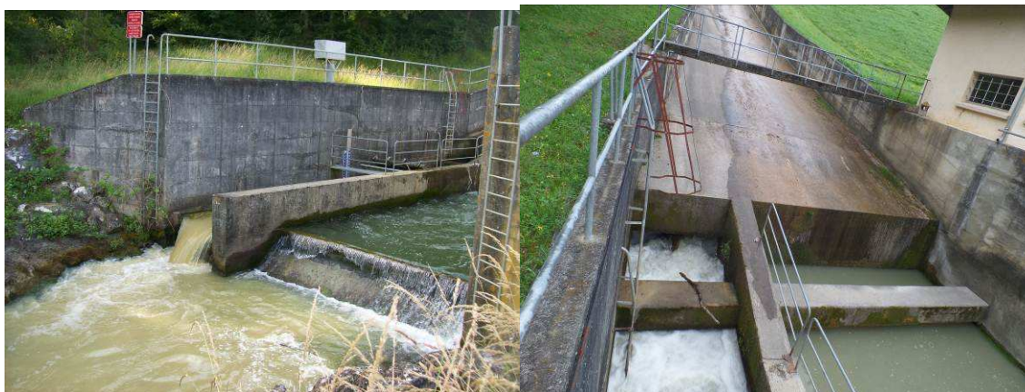
Figure 20 : Bassin de dissipation
